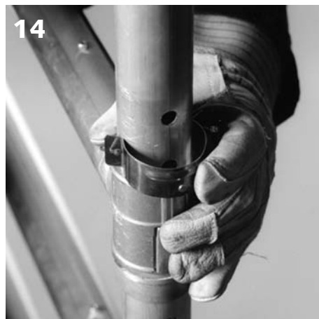
14. Verplaats daartoe de borgclips aan de staander van de rustpositie naar de borgpositie.
