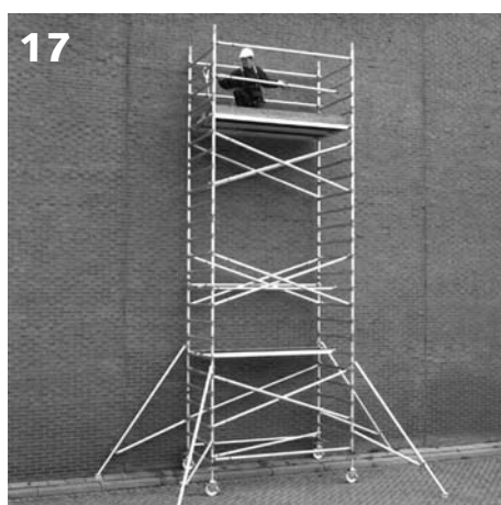
17. Monteer kantplanken op de werkvloer(en) en (her-)verdeel de rustplatforms. Zie ook schema 3 (pag 10).
